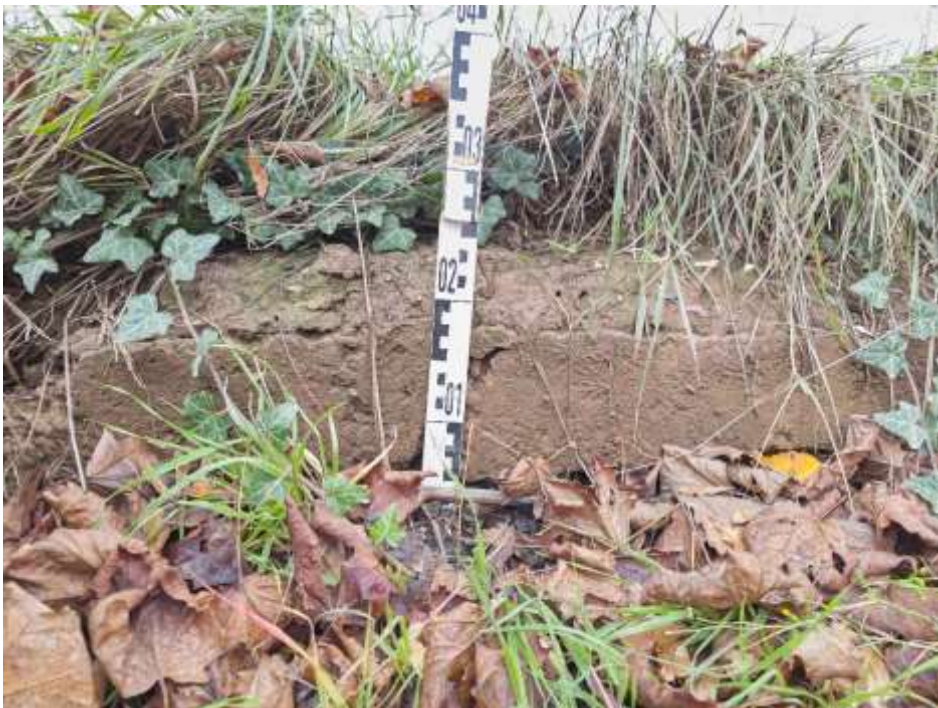
Abbildung 181: Abgrabung im Kronentraufbereich von Baum 661.
