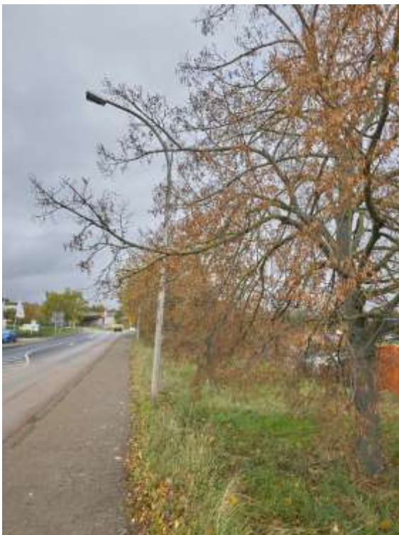
Abbildung 177: Eingeschränktes Lichtraumprofil an Baum 660.
