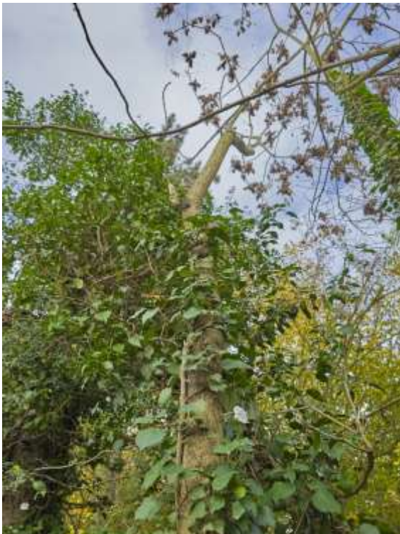
Abbildung 73: Krone mit Astabbruch von Baum 622.
