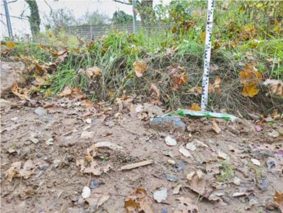
Abbildung 154: Abgrabung am äußersten Rand des Wurzelbereiches von Baum 649.
