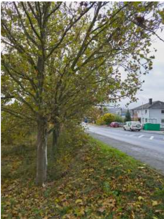
Abbildung 161: Eingeschränktes Lichtraumprofil an Baum 652.
