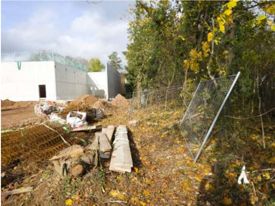
Abbildung 62: Materiallagerung und Eingriffe im Boden des Kronentraufbereichs von Baum 618.
