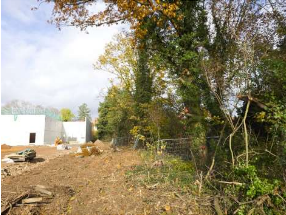
Abbildung 47: Eingriffe im Boden im Kronentraufbereich von Baum 614.
