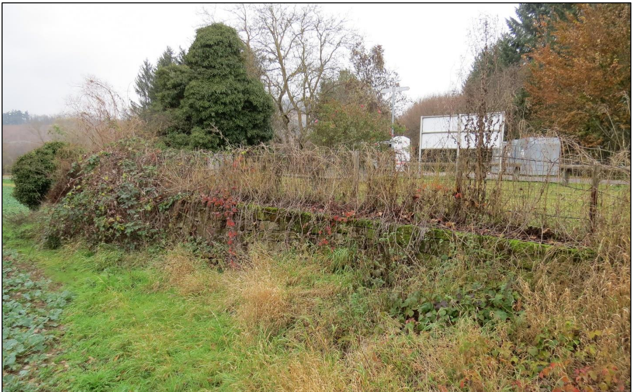
Abbildung 11: Mauer unterhalb des Ruheplatzes im Nordosten der Planung
