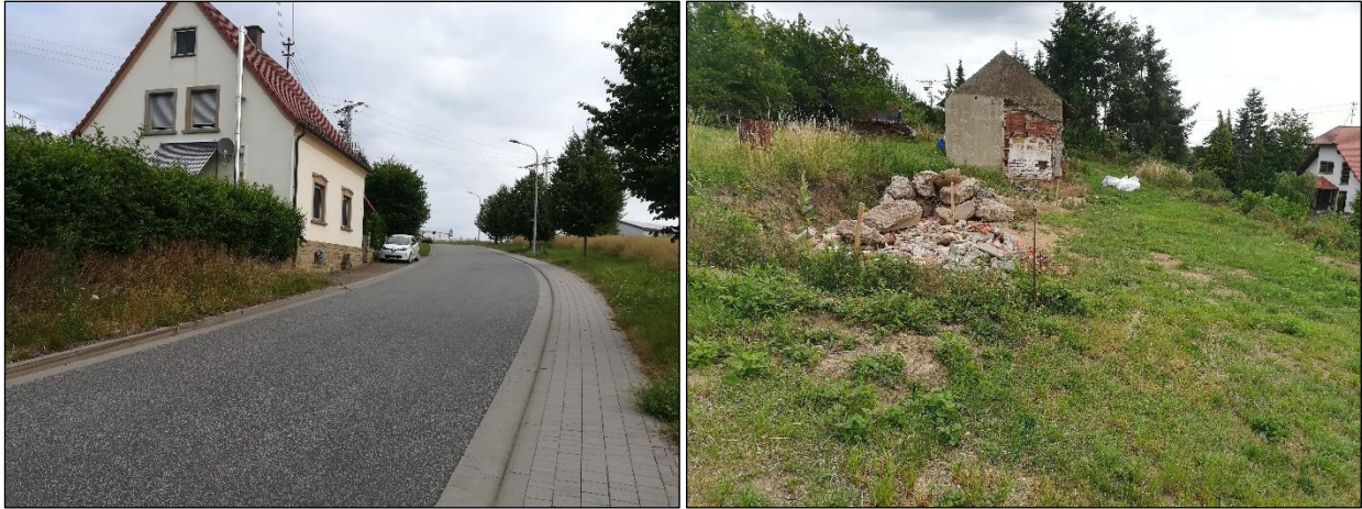
Abbildung 2: Blick nach Norden entlang der Straße „Oberdorf“ auf die Bestandsbebauung (Foto links; Blick auf Flurstück 3894/1 und teilweise bereits abgebrochenen Gebäudebestand bzw. den vorhandenen Schuppen (Foto rechts) des Flurstücks 3894/3
