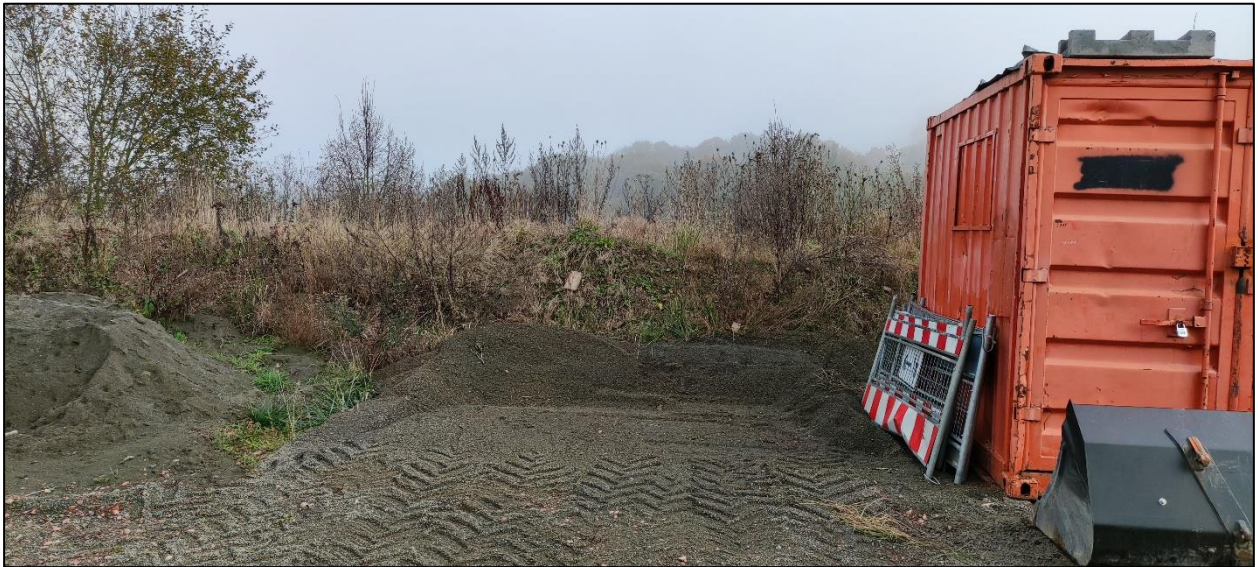
Abbildung 11: Erdwall mit vorgelagerten temporären Materiallagerungen (Foto: gutschker & dongus 2021)
