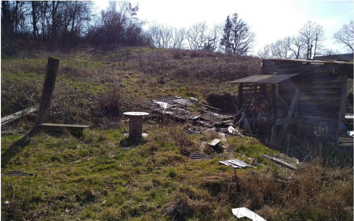
Abb. 6: zerfallende Gartenlaube zentral im Plangebiet
