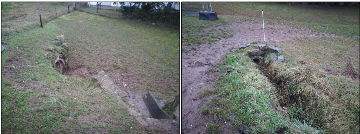
Abbildung 15: Blick auf das Ende der Verrohrung des Otzweiler Grabens (unterhalb der Römerstraße) (Foto links) und Verrohrung des Versickerungsgrabens im Zufahrtsbereich auf die Weide unterhalb des Wirtschaftsweges (Foto rechts) (Fotos: GUTSCHKER-DONGUS 2021)
