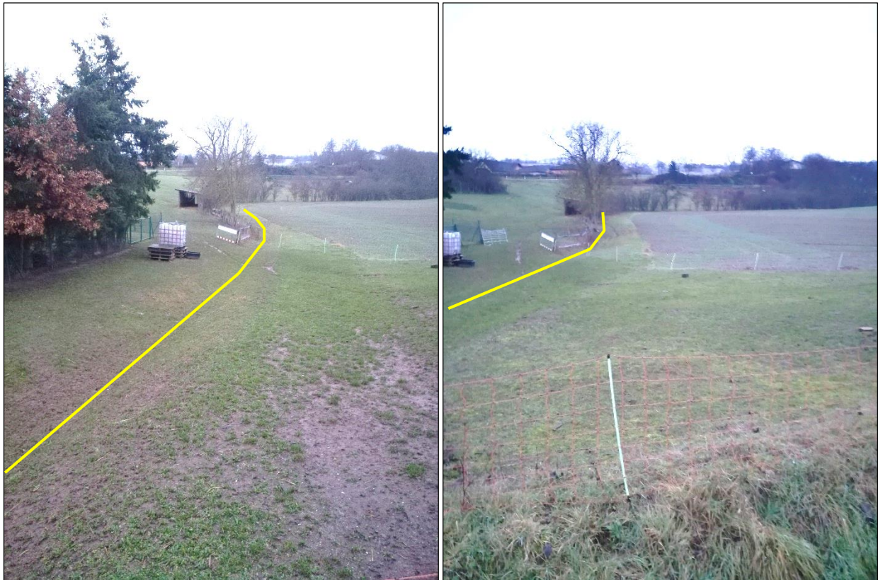
Abbildung 16: Blick auf den Verlauf des Otzweiler Graben (gelb skizziert) als Mulde am östlichen Rand außerhalb des Geltungsbereichs (angrenzend zu einem grasbewachsenen Wirtschaftsweg) (Foto: GUTSCHKER-DONGUS 2021)
